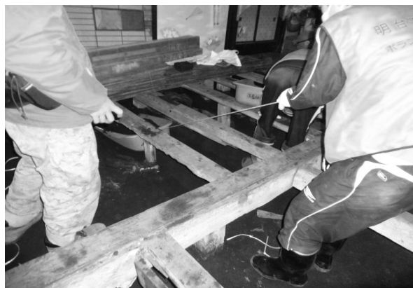
作業中の様子
